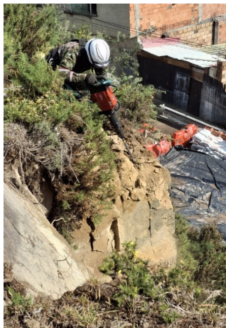
Remoción controlada de bloques con martillo rotopercursor
